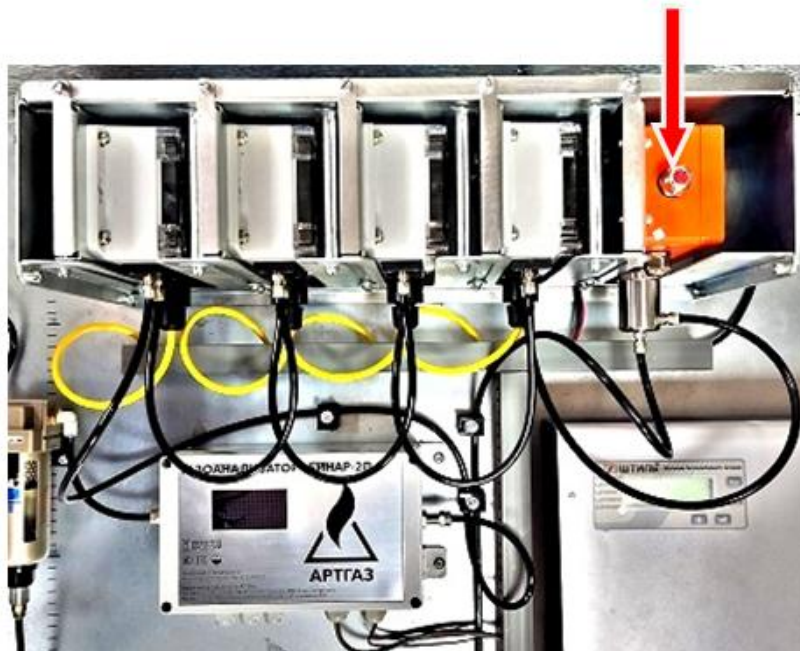
Рисунок А.20 - Полка с газоанализаторами
