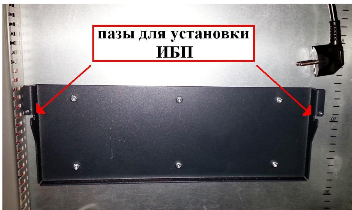
Рисунок А.4 – Кронштейн для установки ИБП
