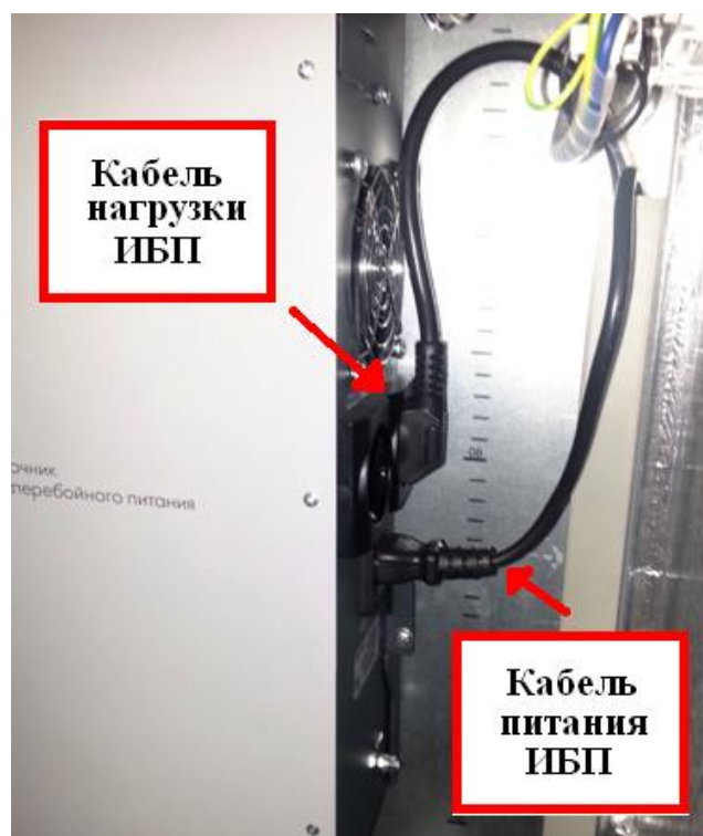
Рисунок А.6 – Кабель питания и кабель нагрузки ИБП
