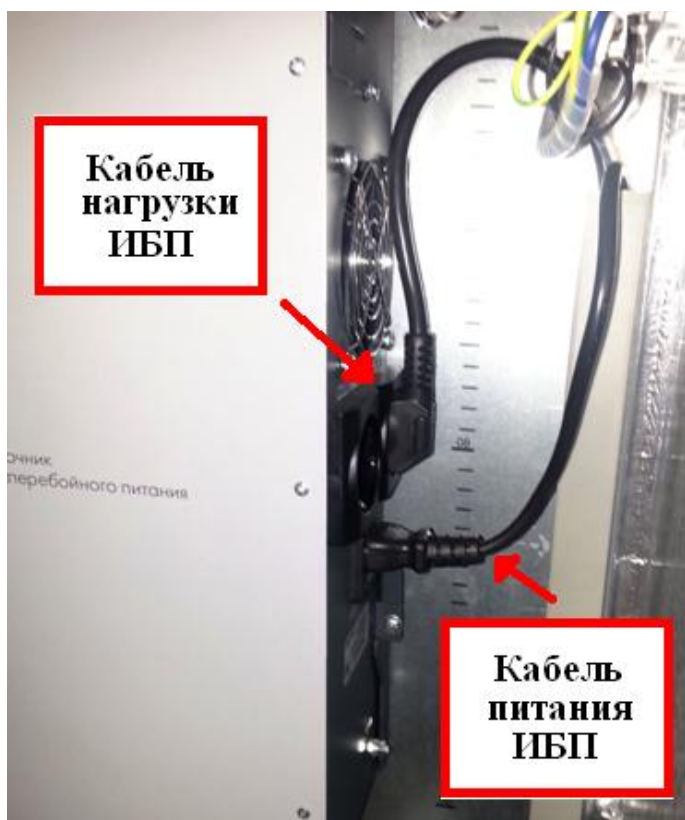
Рисунок А.7 – Кабель питания и кабель нагрузки ИБП
