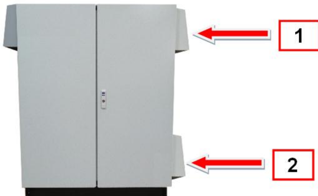
Рисунок А.9 - места установки фильтров
